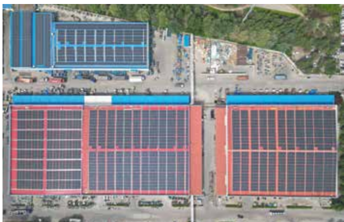
60MW 山东东营分布式光伏项目
