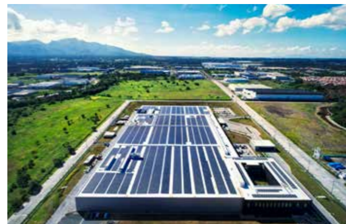
4.77MW 菲律宾八打雁省分布式光伏项目
