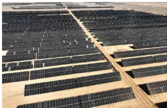
240MW 新疆一师地面光伏项目
