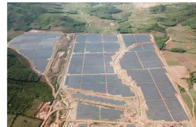
100MW 越南清化地面光伏项目
