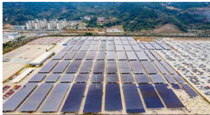
福建最大光伏车棚项目
