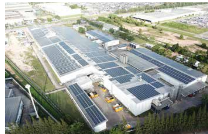
3.3 MW 泰国罗勇府分布式光伏项目
