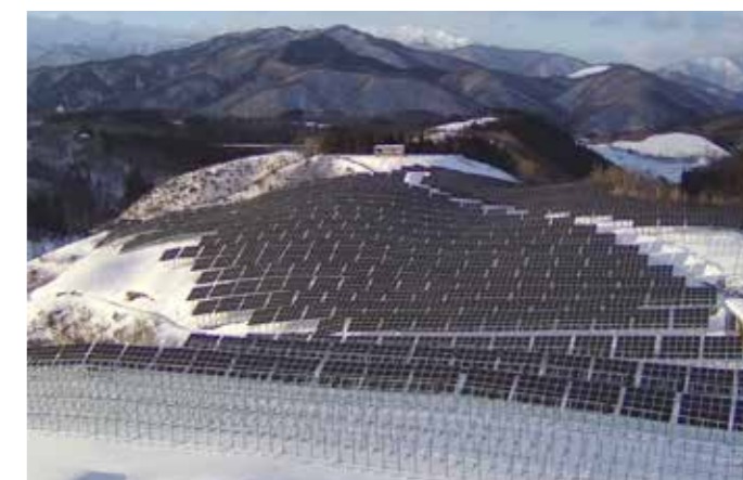
30MW 日本岐阜县高山市地面光伏项目
