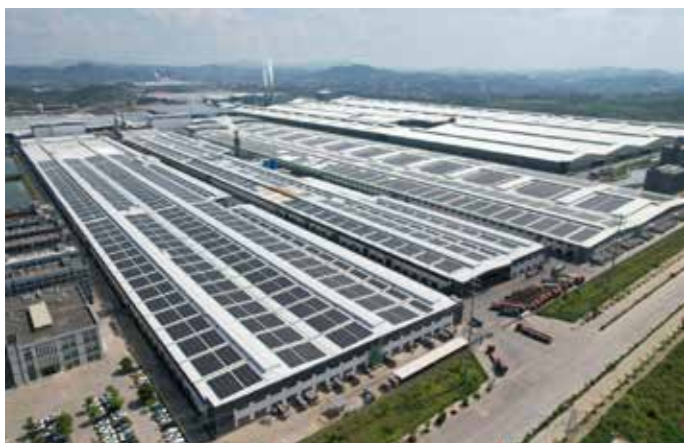
40MW 广西梧州分布式光伏项目
