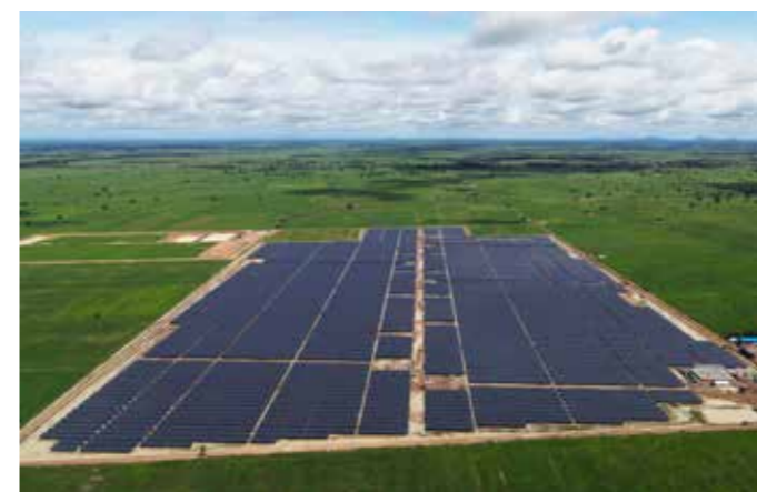
39MW 柬埔寨班迭棉吉省地面光伏项目
