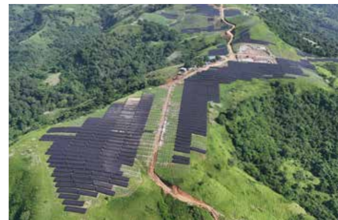
221MW 菲律宾奥隆阿坡地面光伏项目
