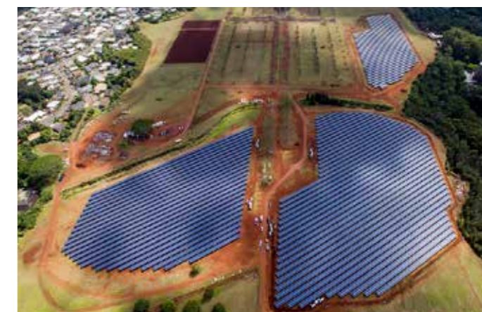
7.6MW 美国夏威夷地面光伏项目
